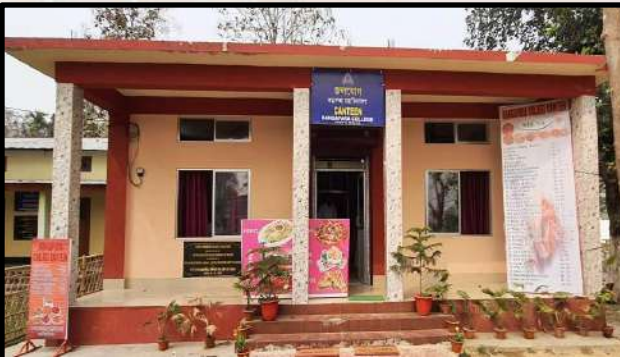
RUSA ৰ পুঁজিৰে নিৰ্মিত মহাবিদ্যালয়ৰ জলযোগকক্ষ A CANTEEN has been constructed with the fund released by RUSA
