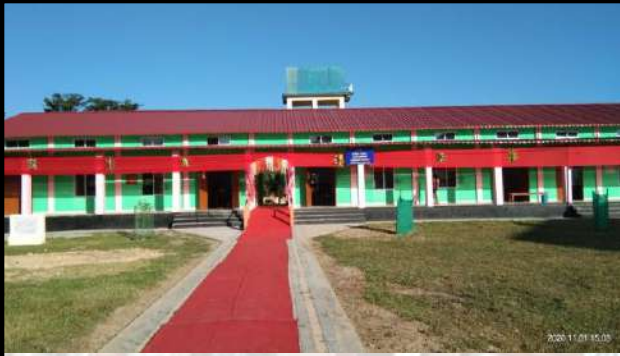
পাৱাৰগ্ৰীডৰ সৌজন্যত নিৰ্মিত মহাবিদ্যালয়ৰ শ্ৰেণীকোঠাসমূহ। New classrooms of the College constructed by the fund received from POWERGRID.
