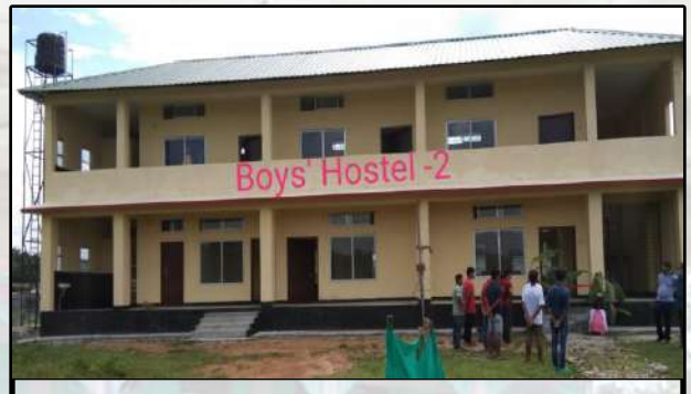
নৱনিৰ্মিত দুমহলীয়া ছাত্ৰাবাস View of newly constructed two storied boys hostel
