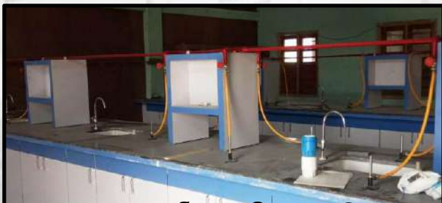
বিজ্ঞান শাখাৰ নিৰ্মাণমান পৰীক্ষাগাৰৰ এটি দৃশ্য A view from the Science laboratory under construction
